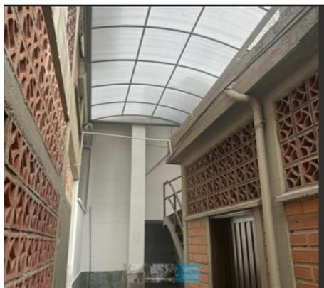
Se realizó instalación de teja tipo panel sobre salón de capacitación con lo que mejoró el aislamiento térmico mejorando la temperatura del lugar y posteriormente se procedió a la adecuación interna del mismo.
